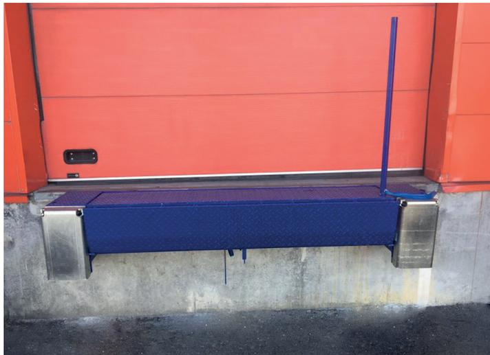
Le pont de chargement Easy Dock est utilisé pour les opérations de **chargement et de déchargement des véhicules** avec un niveau de plancher supérieur ou inférieur à la hauteur de quai. Il assure une parfaite liaison avec le camion pour un **passage en toute sécurité** avec un chariot élévateur.
